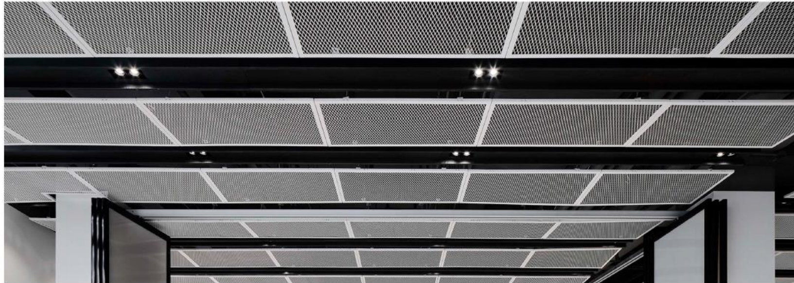
*照片拍摄于上海市徐汇区华展东路小学
